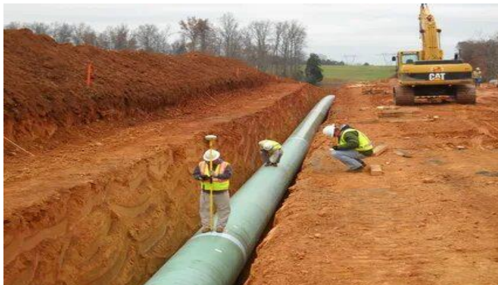
Рисунок 1. Процесс строительства инженерных коммуникаций [6]
